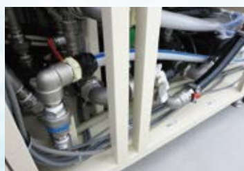
狭所配管（RO装置内）
